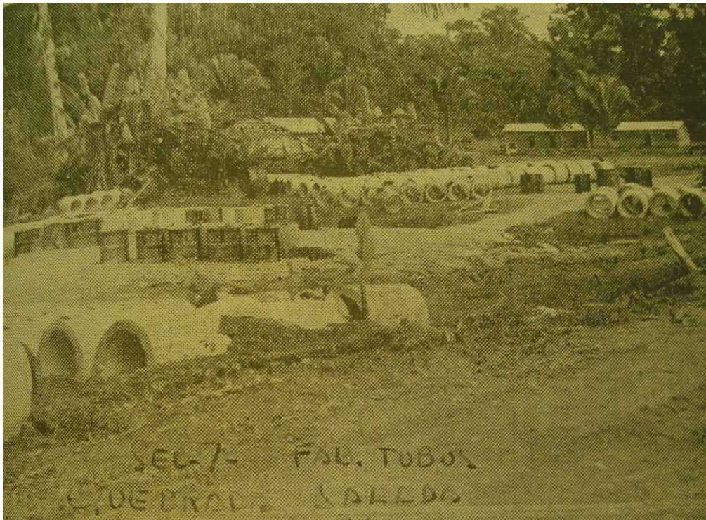
Imagen 5 Fábrica de tubos de cemento. Estas fábricas fueron instaladas en cada uno de los frentes de construcción este corresponde a Agua Salada. Diario de Centro América 18 de enero 1952 pág. 5.
